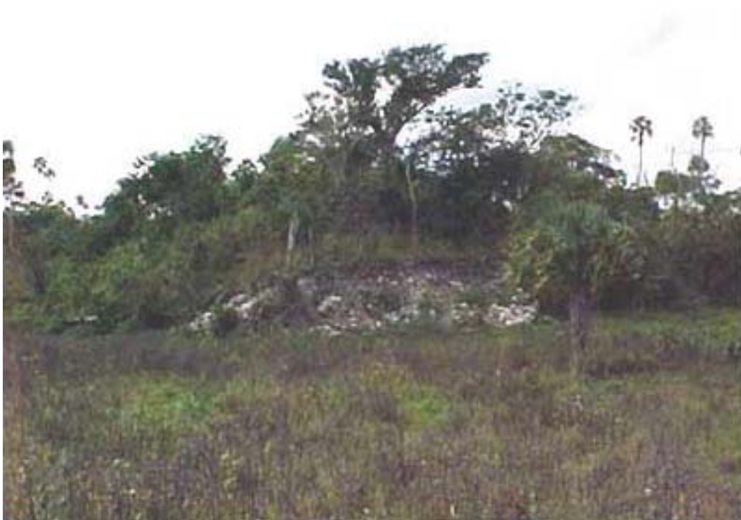
Foto 34. Estructura mayor de la plaza central del sitio 5 (Nuevo León). Se puede notar el saqueo reciente de la misma.
