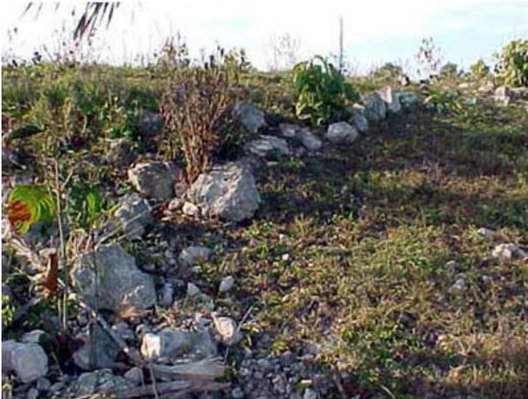
Foto 49. Muro de contención aún visible de una plataforma del sitio 19.
