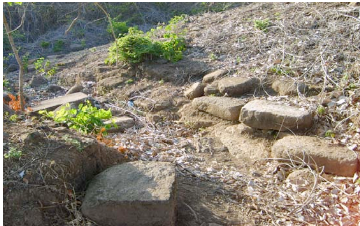
Fig. 3.5. Erosión ocasionada por drenaje, paso peatonal, siembra y ganadería
