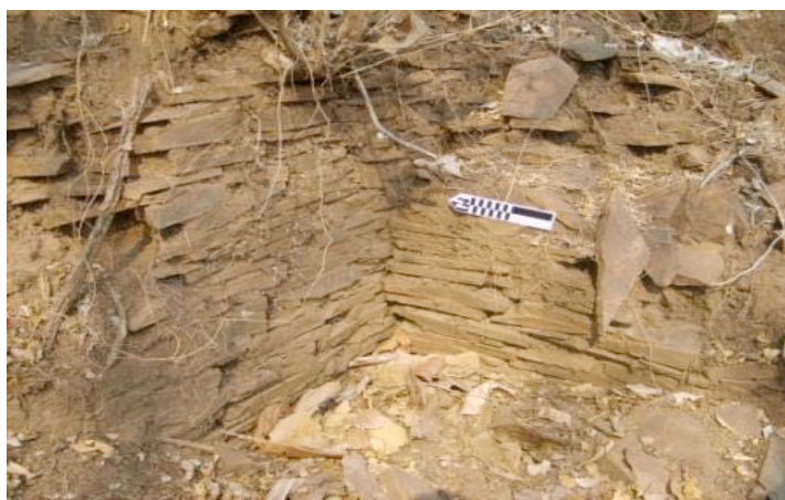
Fig. 3.20. Detalle de una esquina interna donde se puede observar la unión de la escalinata y la plataforma con fachadas de lajas.
