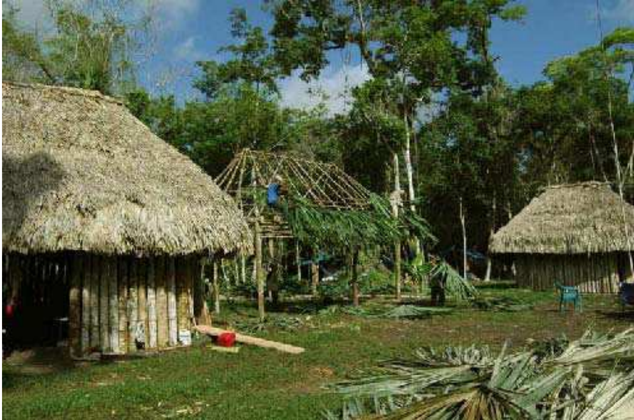
Figura 19. Cival, campamento en construcción en la orilla de la aguada de La Union.
