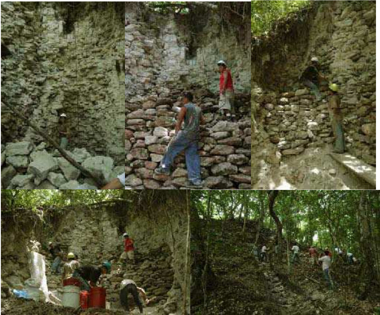
Figura 44. Cival, Estructura 1, trinchera este en fases de relleno (arriba e izquierda). Trinchera norte rellenándose (derecha).
