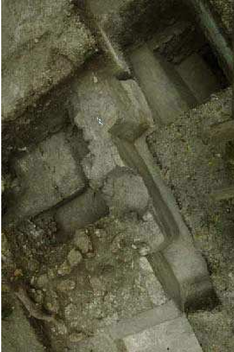
Figura 5. Vista del lado este de los cuerpos escalonados del Edificio N en la excavación HOL.T.71. En el margen izquierdo se nota una fase constructiva anterior debajo del edificio
