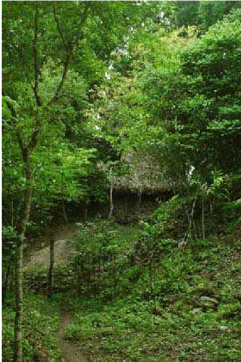
Figura 8. Edificio B, Grupo II en su estado actual (desde el sur).
