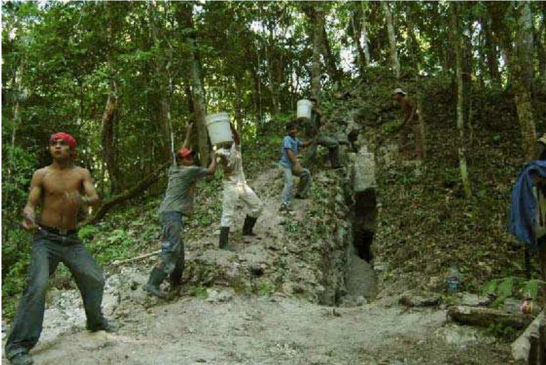
Figura 27. Rellenando la trinchera en el Grupo IX.
