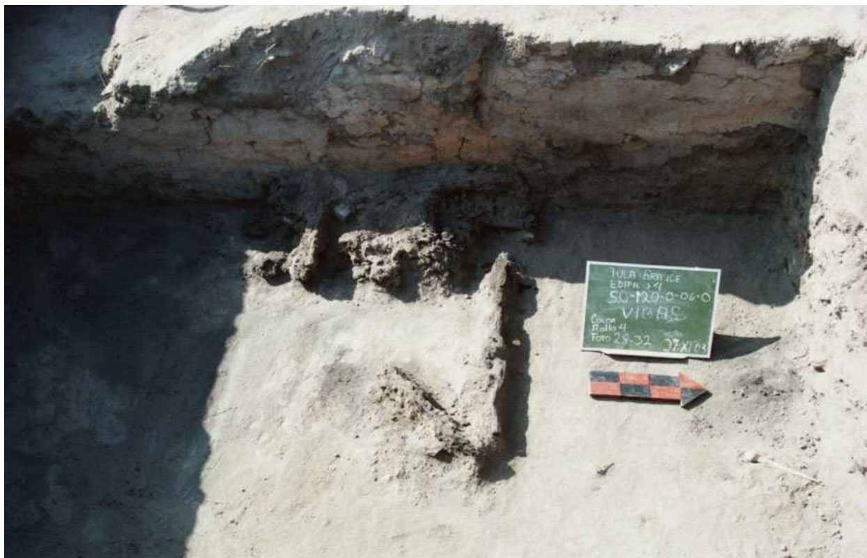
Figura 42. Al colapsarse el techo, éste se encontraba en llamas, lo cual generó las paredes de los muros de adobe sufrieran los efectos del fuego.
