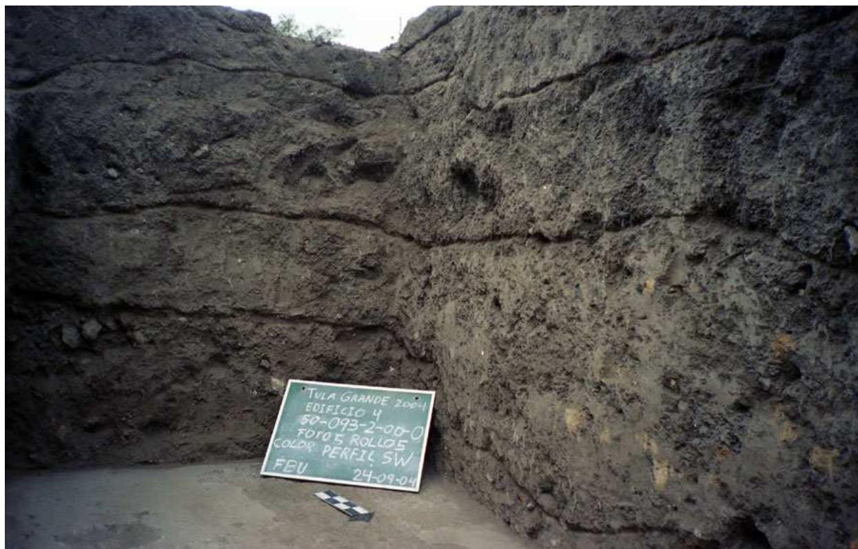
Figura 49. El relleno para la nivelación de la superficie en esta área, fue una actividad que se dio de manera extensa, pues en gran parte de la estructura, se cubrió con materiales para rellenar hasta lograr alturas de más de dos metros del nivel del piso tolteca.
