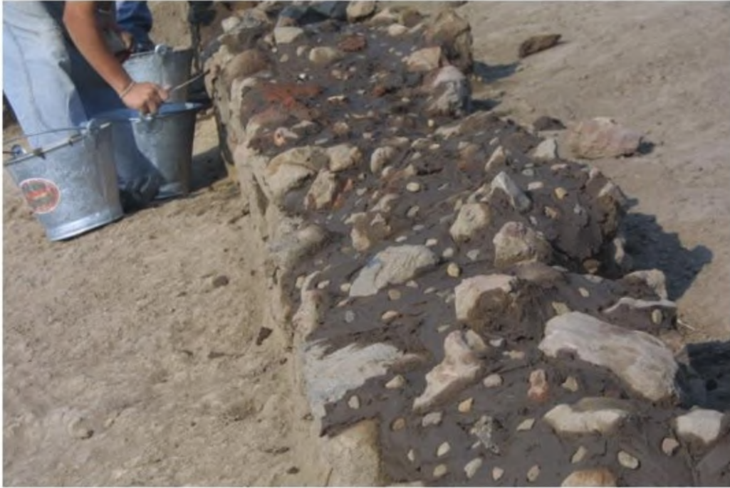
Foto 23. Consolidación de los muros.
