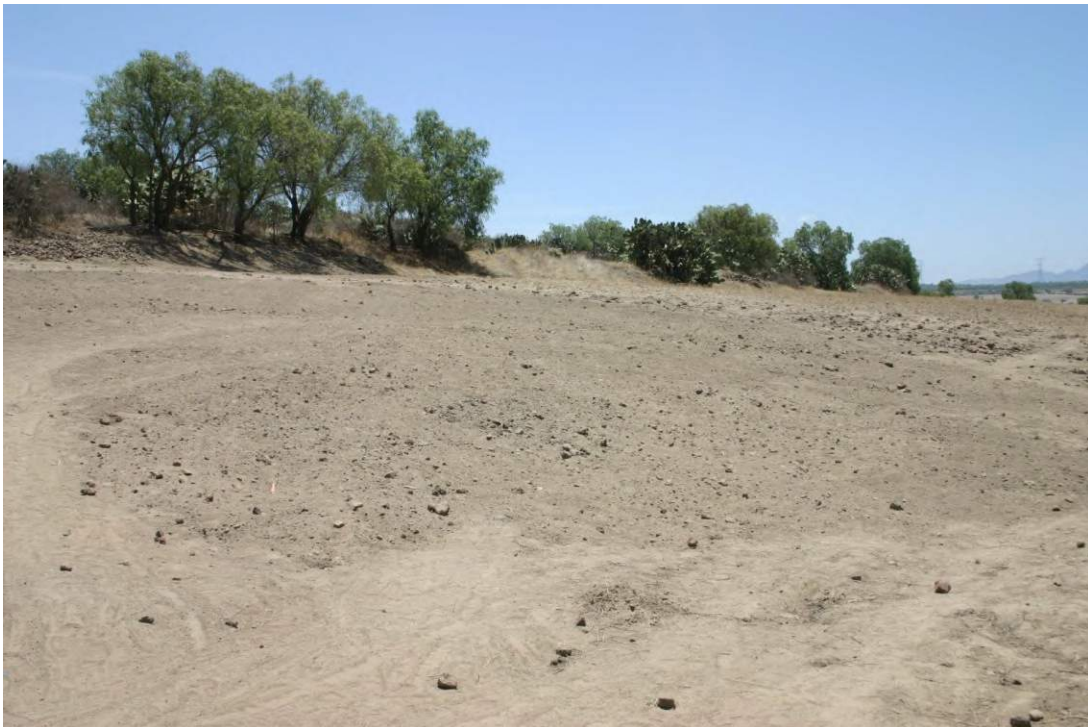
Foto 24. Cierre de la excavación.
