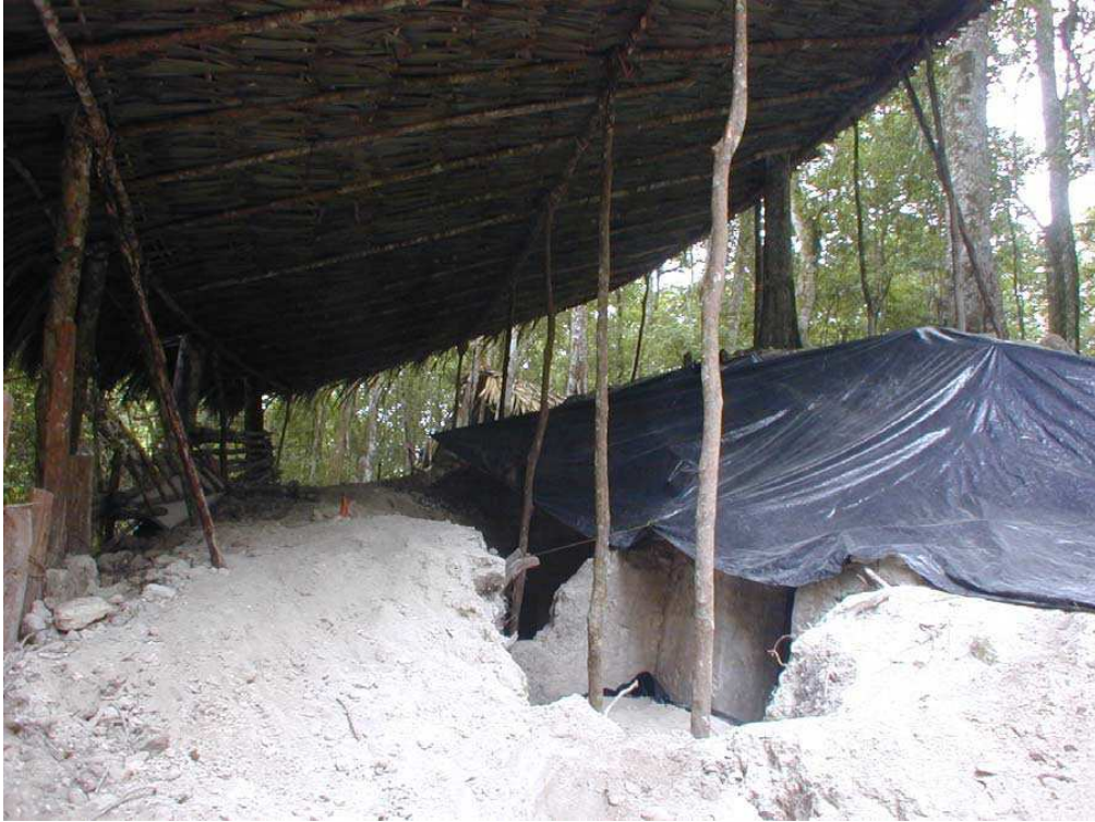
Figura 14. Techo y protecciones a la Estructura 1 de La Sufricaya.
