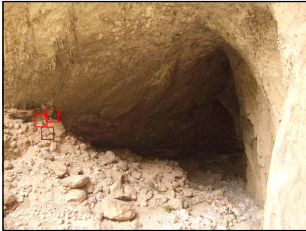
① Vista del extremo Noroeste del túnel. Los marcos rojos muestran a tres miembros del proyecto explorando el área de las pozas.
