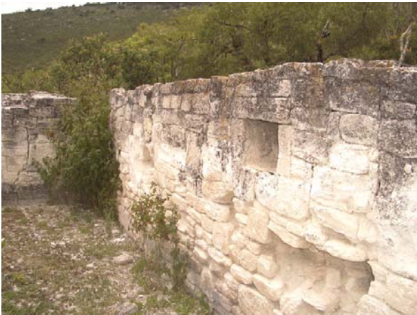
El cuarto Este con un nicho en el muro Este cerca del extremo sur.
