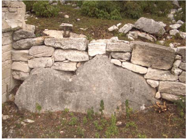
Muro Este del patio (adición reciente).
