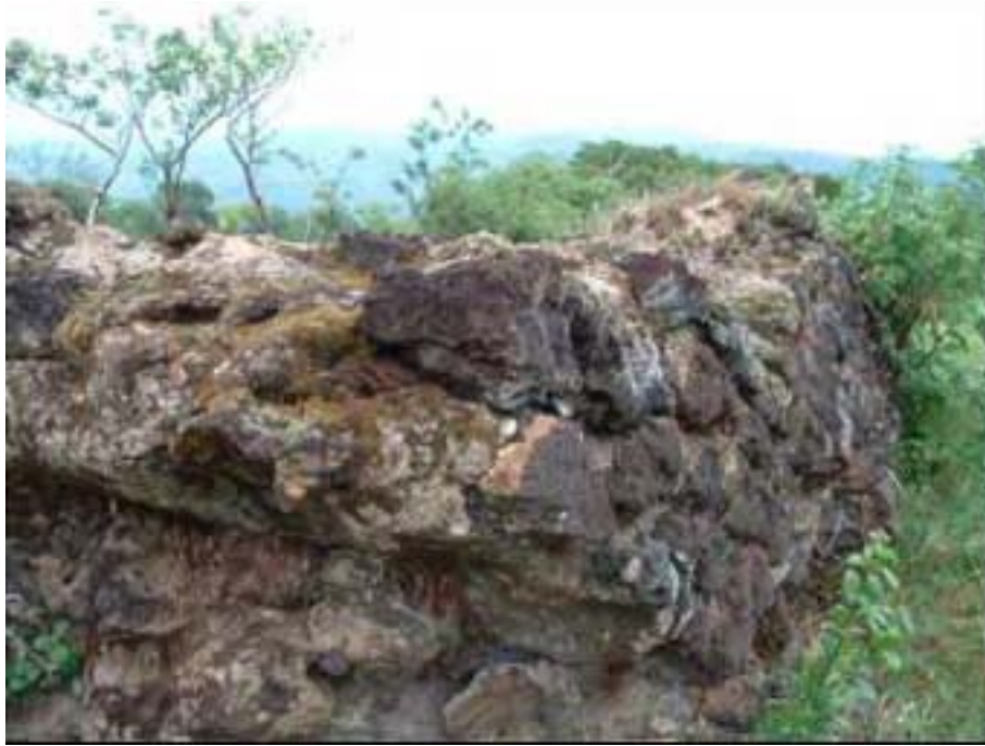
Figura 6. Paredes de Mortero sobre Plataforma mayor (Zona de Muros).
