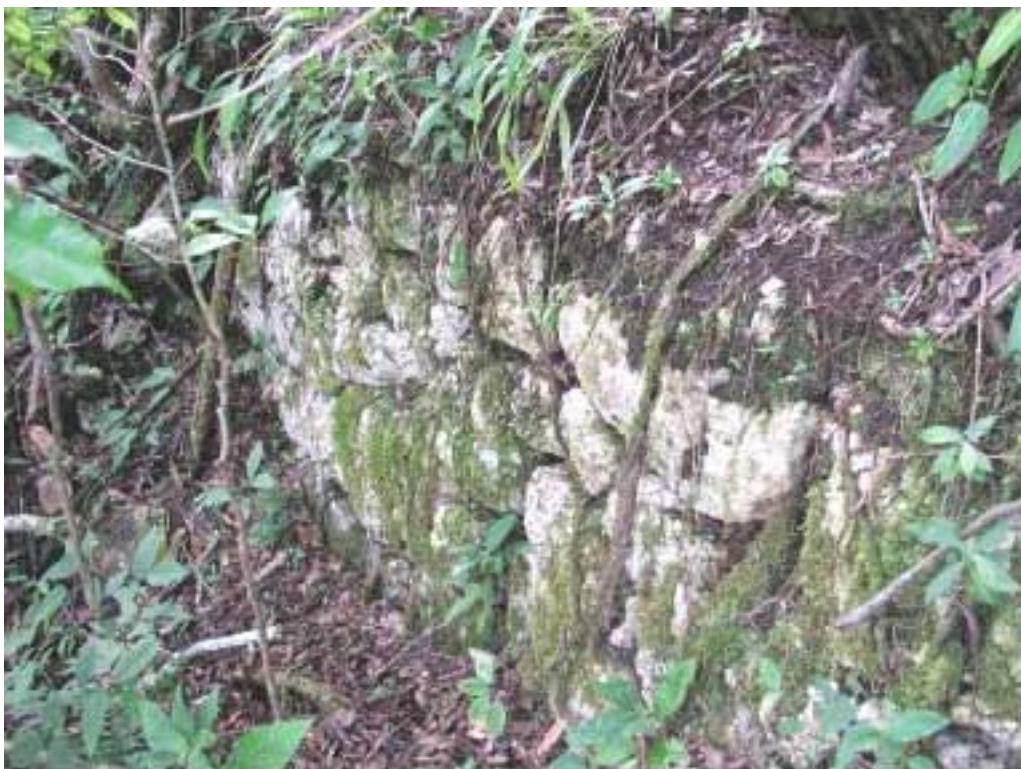
Lámina 26. Álvaro Obregón 2, muro de la plataforma.
