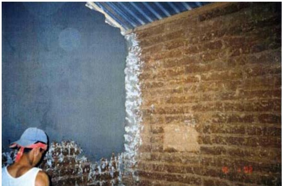
Figura 8. Reparación de la estructura.
