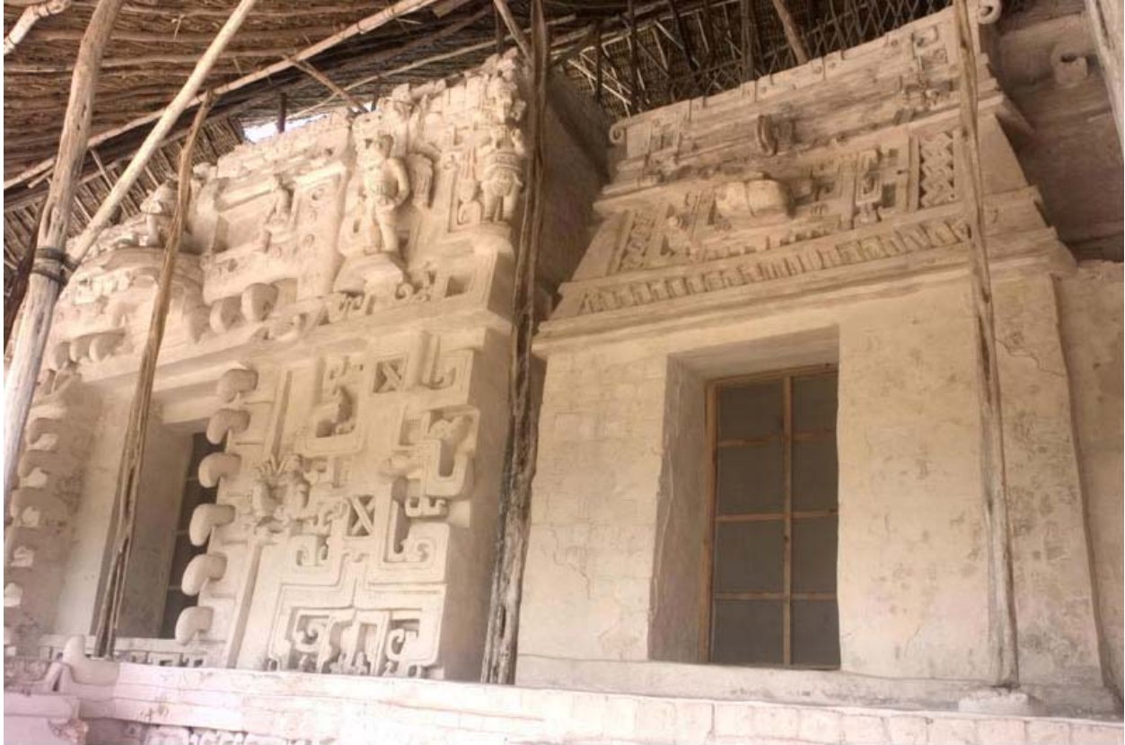
Foto 1. Detalle de la fachada de la Estructura 1. (Fotografía © de Justin Kerr, 2004.)
