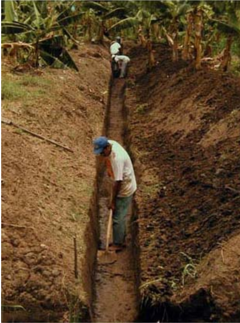
Figura 14. Momento en que se comienza a limpiar el perfil de 50 m documentado como Suboperación 5, mirando hacia el norte.
