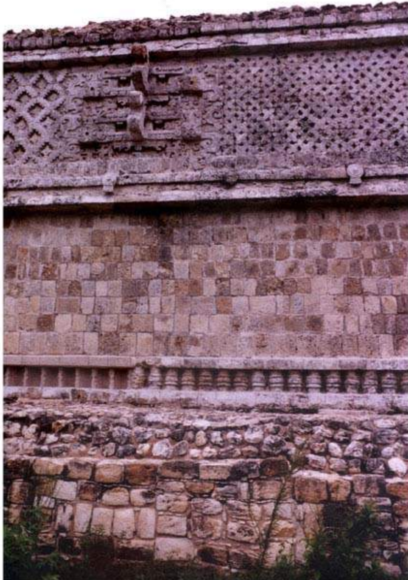
Plate 1.1: The Puuc building (11K2a) at Kulubá after the 2000 restorations (El edificio Puuc (11K2a) de Kulubá, después de las restauraciones del año 2000).
