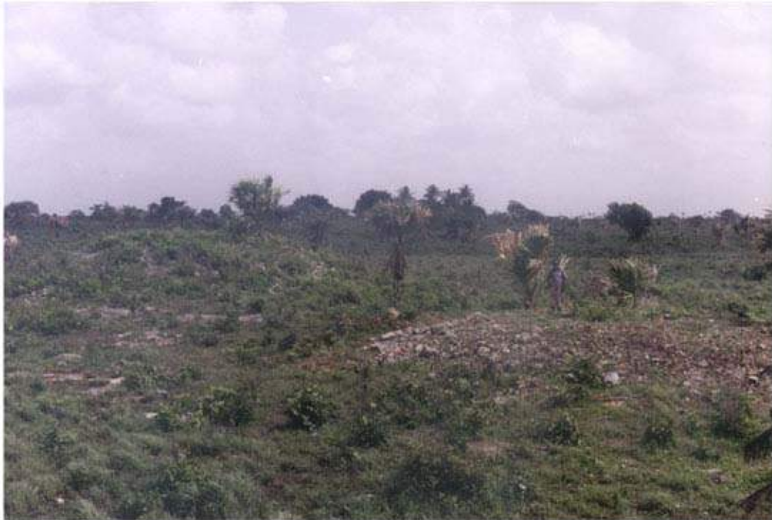
Plate 2.1: View north to San Pedro Structures 16 (l) and 15 (r) from the top of Structure 14 (Vista hacia el norte en dirección a las Estructuras 16 (l) y 15 (r) de San Pedro, desde la cima de la Estructura 14).
