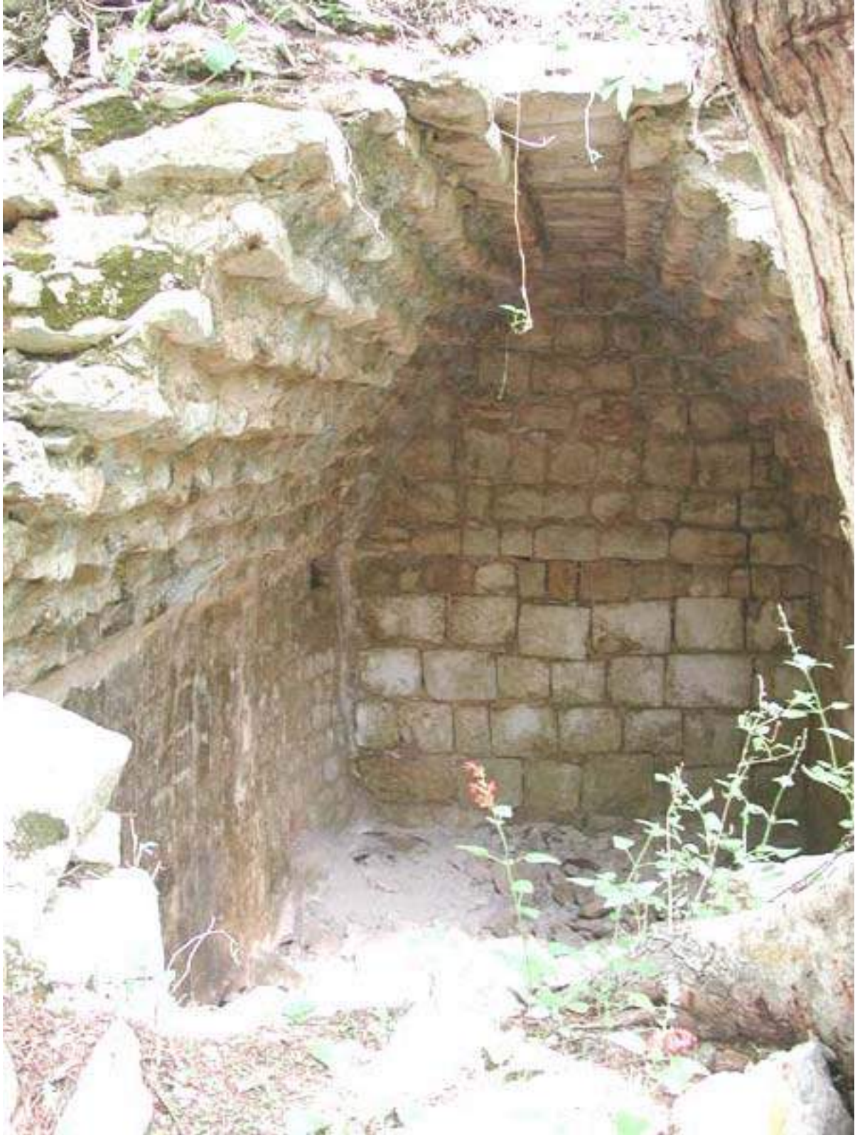
Figura 17. Bóveda escalonada en el Cuarto 1, Estr. N1000E0865, Grupo Chulul.
